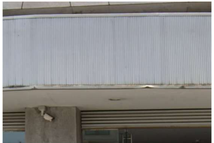
Fotografia 3 – Particolare Vista Ringhiere ed elementi di alluminio da sostituire
